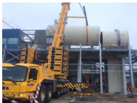
Het plaatsen van de voorwastrommel te Dinteloord
