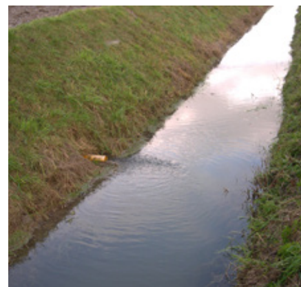
Een goede afwatering wordt bevorderd door goed werkende drainagebuizen. Zorg dus dat de eindbuis open is. Spuit eventueel de drainagebuizen tijdig door.
