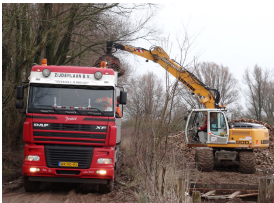
Slecht bereikbare ligplaats met overhangende takken en hinderlijke bomen
