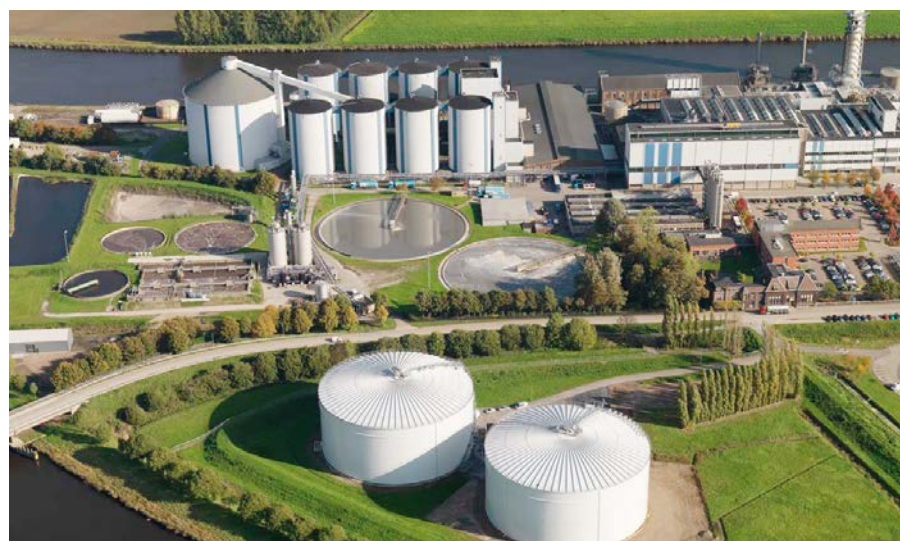
De fabriek in Dinteloord met op de voorgrond twee diksaptanks
