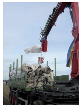
Vliesdoek wordt machinaal aangebracht
