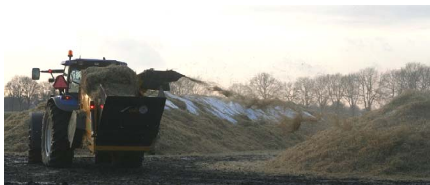
Foto 15 Aanbrengen van stro als isolatielaag
